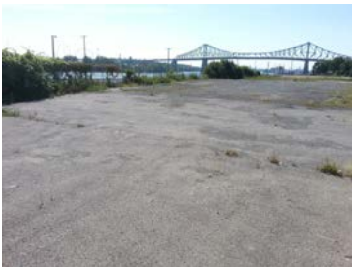
MTQ /silos m'lasse (vue vers l'ouest)
