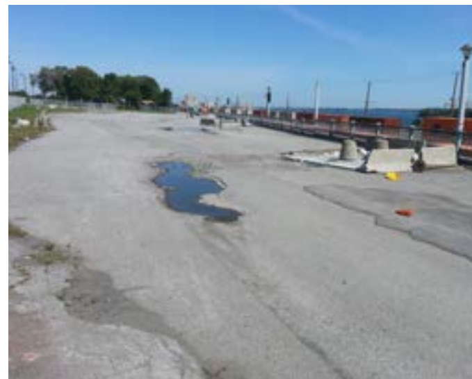
MTQ /dépôt à neige (vue vers l'est)
