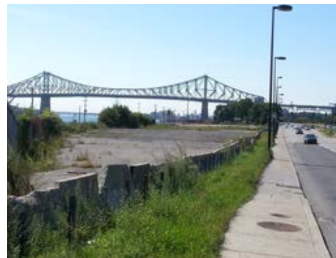
MTQ /silos m'lasse (vue vers l'ouest)
