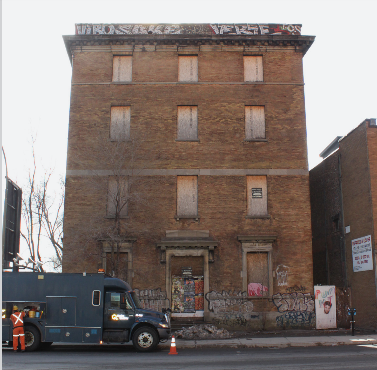
FAÇADE AVANT (ÉTAT ACTUEL)
