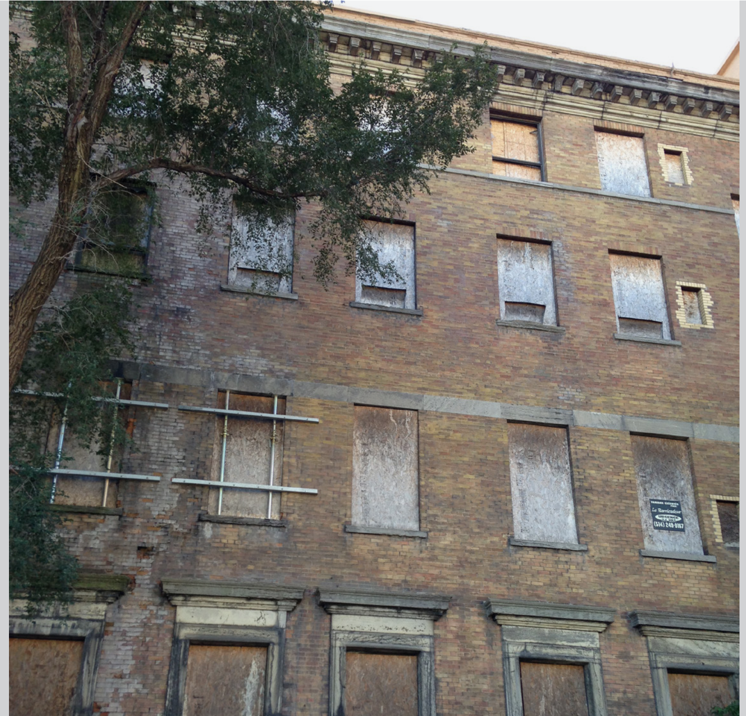
FAÇADE EST (ÉTAT ACTUEL)
