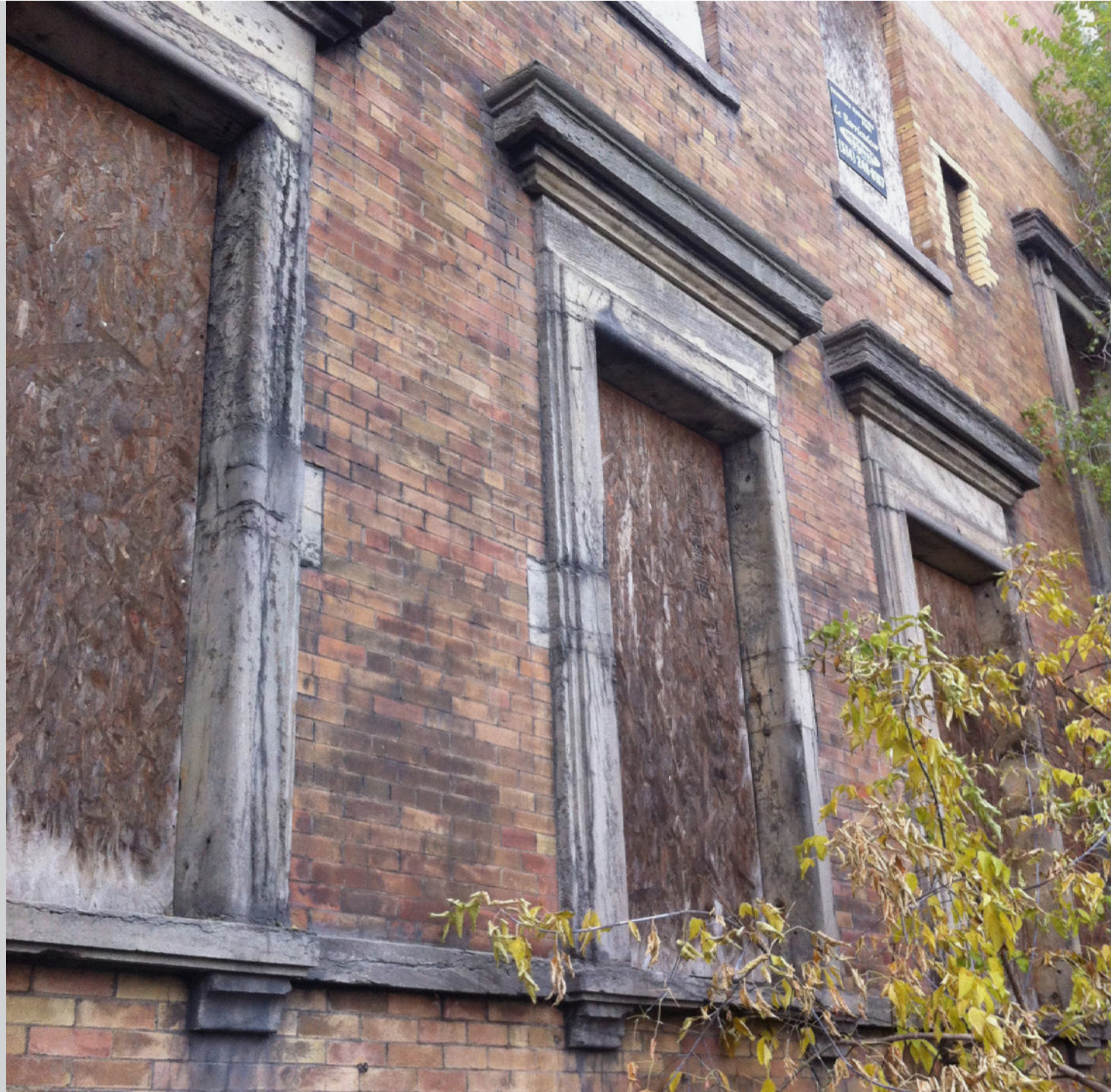
DÉTAILS DES ENCADREMENTS DE PIERRE DE L'ÉTAGE
