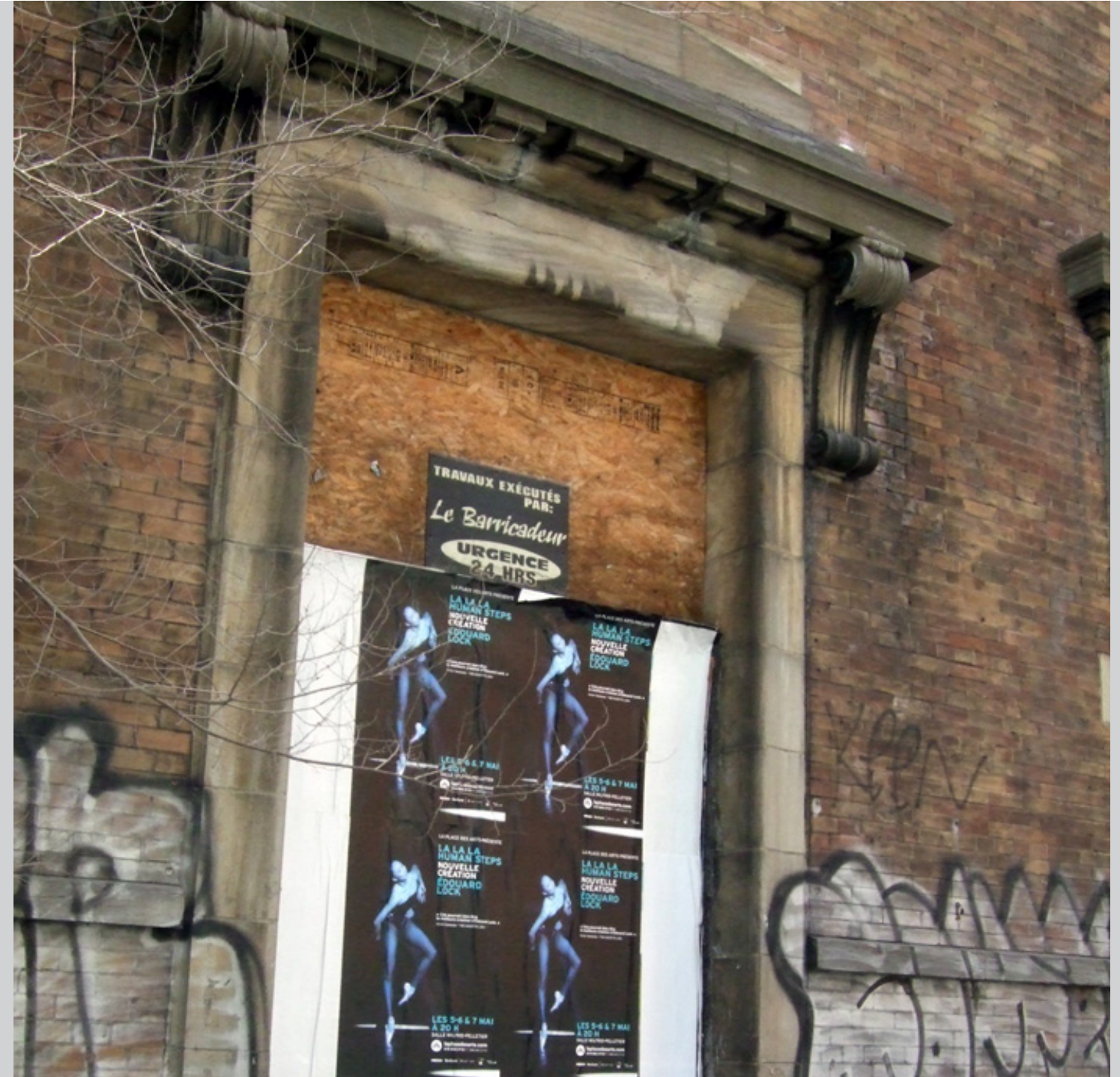
ENTRÉE PRINCIPALE RUE SAINT-ANTOINE OUEST
