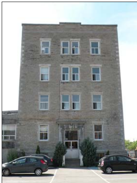
31. Façade principale du 65, rue De Castelnau Ouest.
