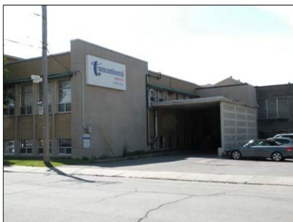
27. Une partie des agrandissements, annexés à gauche du bâtiment à l'étude.
