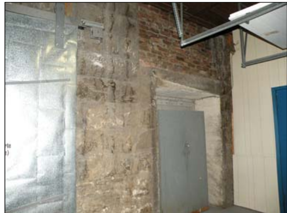
42. Au sous-sol, ancien mur de façade latérale en maçonnerie, devenu un mur mitoyen percé d'ouvertures lors de l'ajout du premier agrandissement, à l'ouest du bâtiment d'origine.
