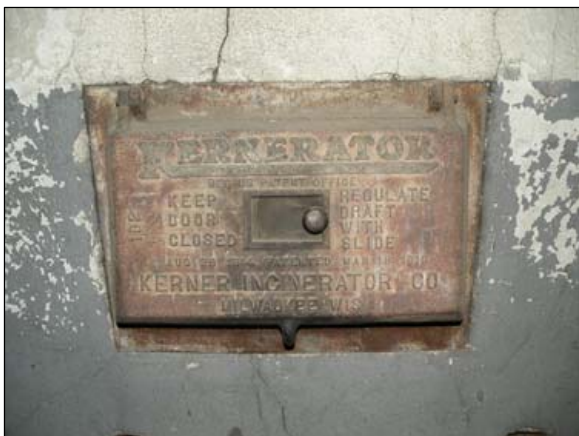
47. Une des trappes de la cheminée.
