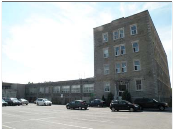
32. Façades avant et latérale est du bâtiment, avec une partie des agrandissements à gauche.
