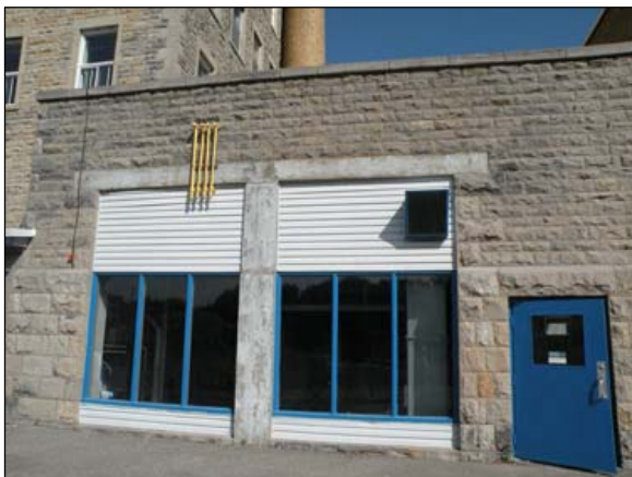
37. Chaufferie annexée à l'arrière du bâtiment à l'étude, qui desservait également le bâtiment principal de l'Institution des sourds-muets.
