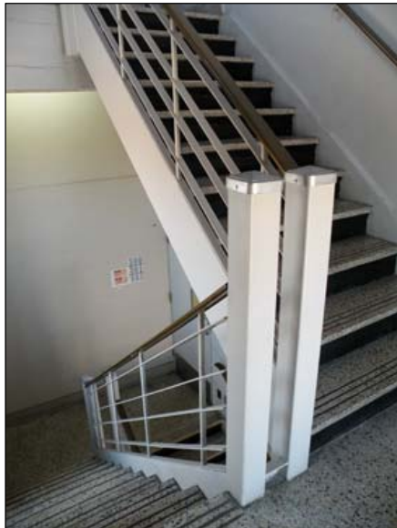
63. Escalier principal avec marches en terrazzo et garde-corps en acier.
