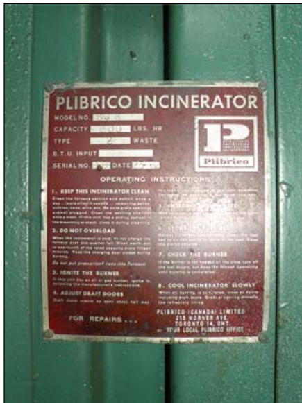
45. Plaque d'identification de l'incinérateur, dont la date inscrite semble être le 25/9/62.
