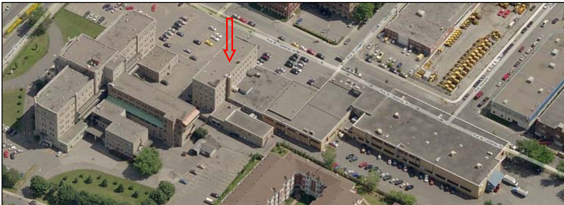
19. Vue aérienne axonométrique du site en direction sud-est, sur laquelle on distingue la haute cheminée cylindrique du 65, rue De Castelnau Ouest et la façade arrière du bâtiment. Source : Bing Cartes, Microsoft Corporation, MDA Geospatial Services Inc., 2012.
