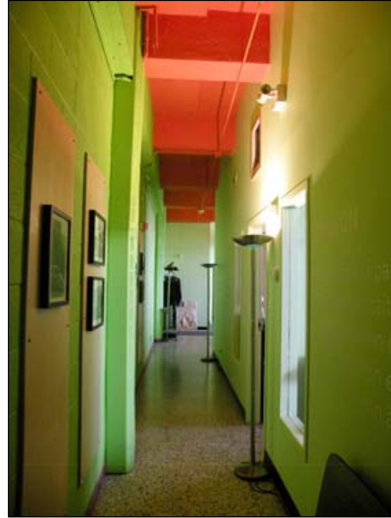
62. Couloir du 2 e étage, avec plancher en terrazzo et poutres et colonnes centrales apparentes.
