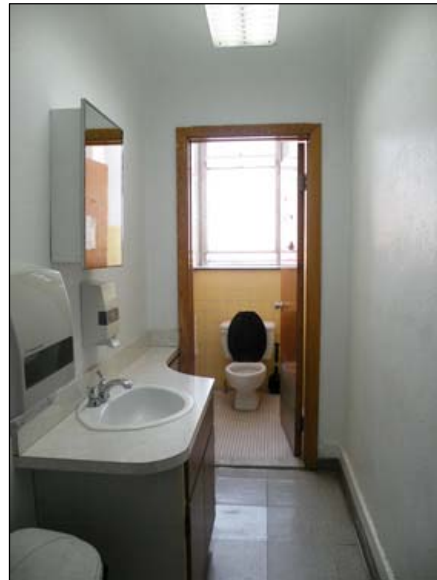
64. Salle d'eau, dont la plupart des finis ne sont pas d'origine.
