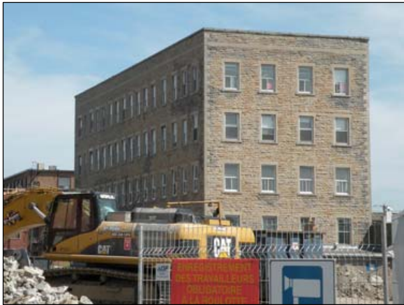
35. Façades latérale est et arrière.
