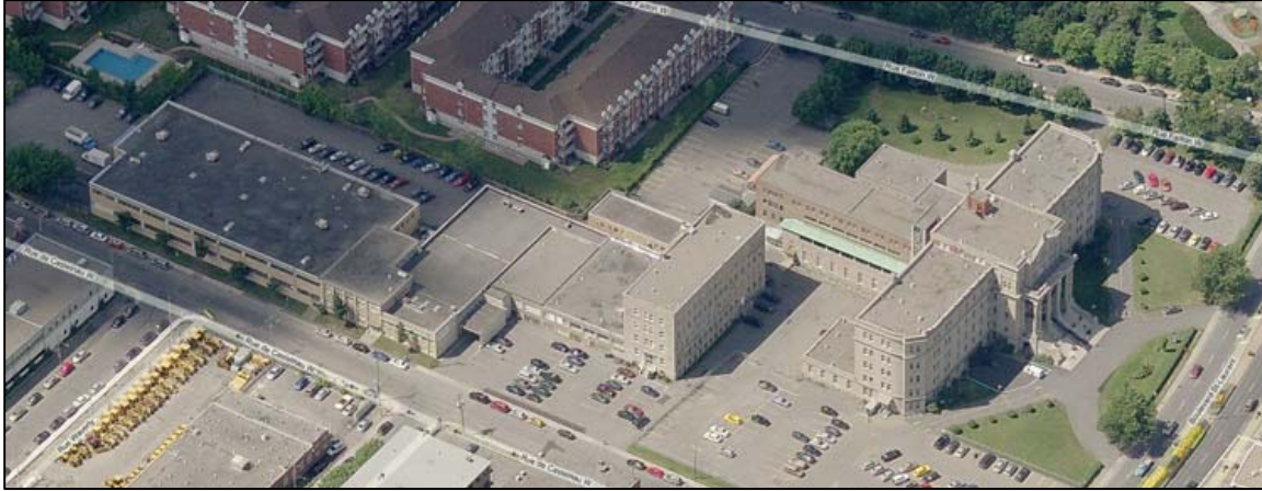
18. Vue aérienne axonométrique du site en direction nord-ouest, permettant d'apercevoir derrière l'ensemble du 65-95, rue De Castelnau Ouest une partie de l'ensemble résidentiel de la rue Faillon Ouest. Source : Bing Cartes, Microsoft Corporation, MDA Geospatial Services Inc., 2012.
