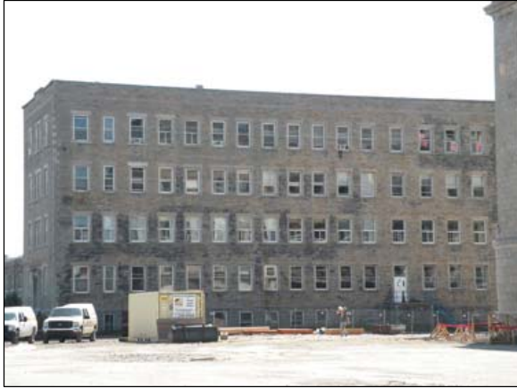
33. Façade latérale est.
