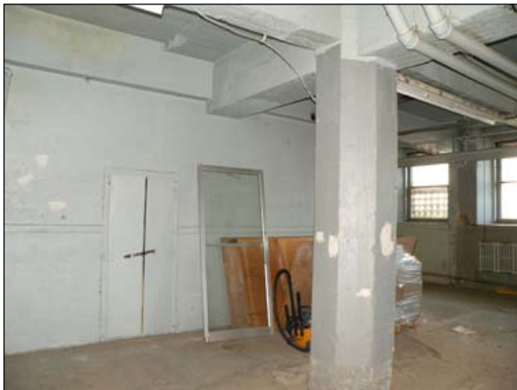
41. Structure de béton apparente dans le sous-sol.
