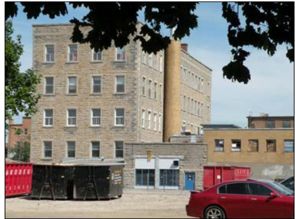
36. Façades arrière et latérale ouest, avec l'annexe de la chaufferie, la cheminée de l'incinérateur et une partie des agrandissements à droite.
