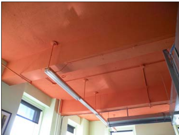
57. Ce local du 2 e étage est l'un des rares endroits où le plafond d'origine en béton demeure apparent.
