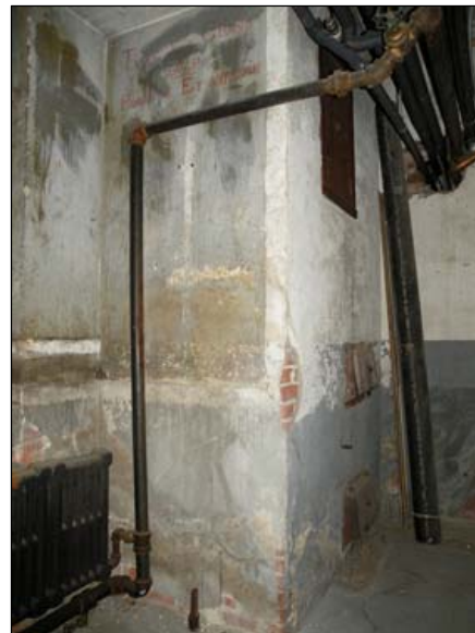
46. Au sous-sol, base de la cheminée de l'incinérateur en brique recouverte de ciment.
