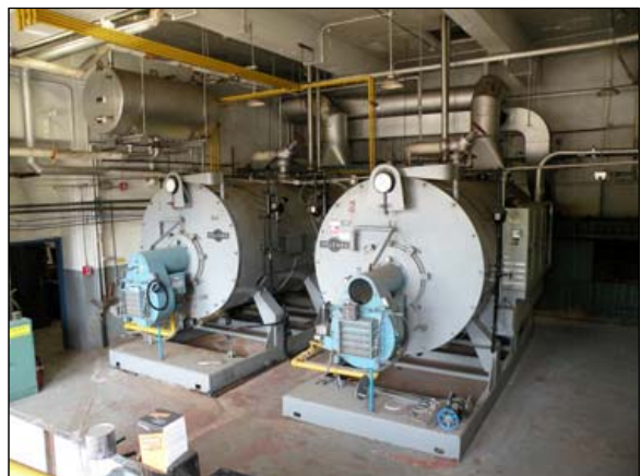
48. Les deux brûleurs dans la chaufferie qui alimentent les ateliers et le bâtiment principal.
