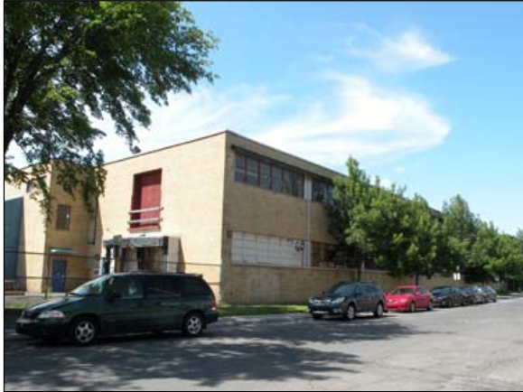
4. Aile « A », la plus à l'ouest de l'ensemble des ateliers, qui serait construite en 1962.
