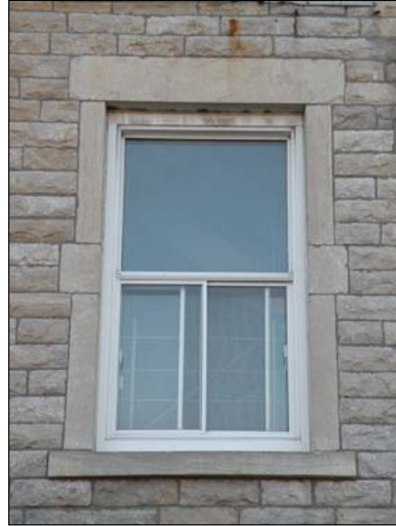
40. Détail de l'encadrement type des ouvertures de fenêtres, également en pierre de taille.
