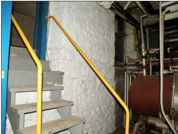
51. De la salle d'équipement mécanique, un accès au garage construit derrière le bâtiment a été aménagé en perçant une ouverture dans le mur.
