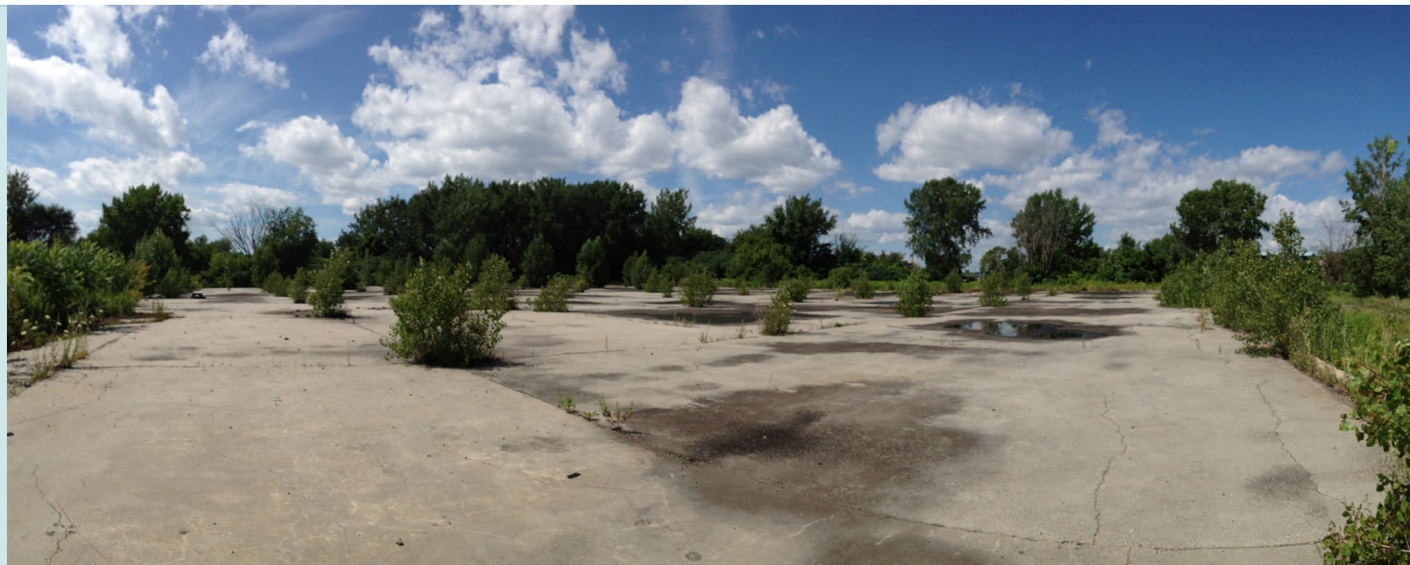
VUE DE LA DALLE DE BÉTON AU SUD DE LA PROPRIÉTÉ
