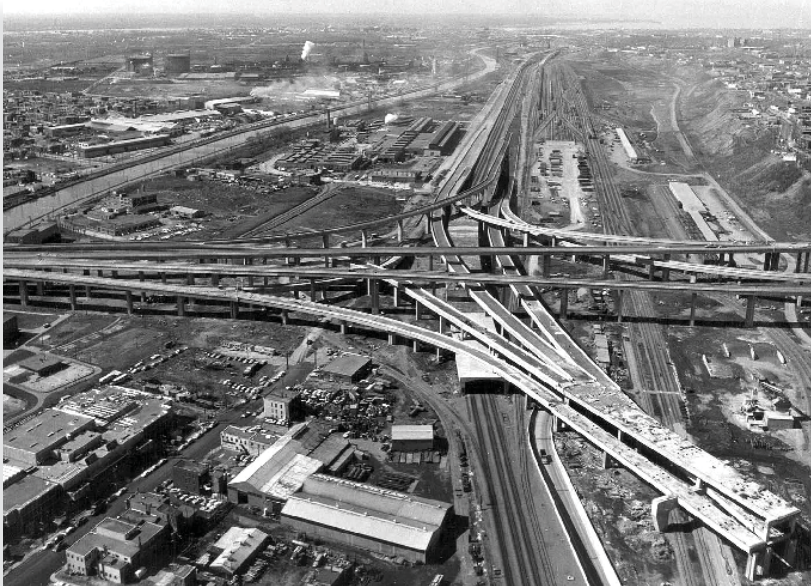
Chantier de l'échangeur Turcot en 1966
