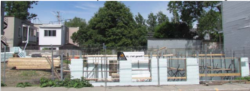
Projet immobilier en construction dans le Village Turcot
