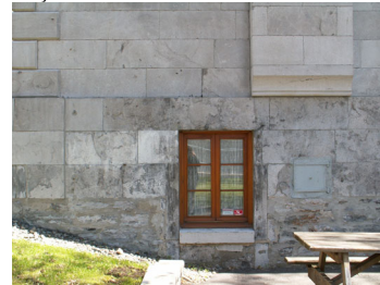
Figure 80 : REF 2005-05-06 JR 005 Détail de la façade ouest de la maison
