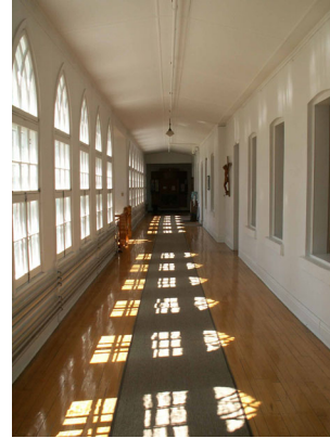
Figure 51 : REF 2005-05-12 LB 072 Cloître; vue vers l'ouest; notez le décroché de la maison Judah d'origine
