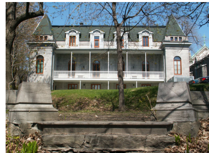
Figure 79 : REF 2005-05-06 JR 001 Façade sud de la maison Masson
