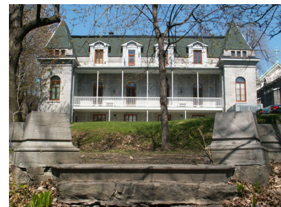
Figure 25 : REF 2005-05-06 JR 001 Façade arrière de la maison
