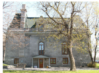
Figure 82 : REF 2005-05-06 JR 003 Façade ouest de la maison Masson
