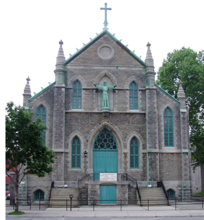
Figure 77 : REF 2005-06-08 JR 030 Façade de la chapelle Saint-François
