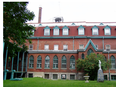
Figure 61 : REF 2005-06-08 JR 070 Traitement de la façade sud du couvent, avec le cloître
