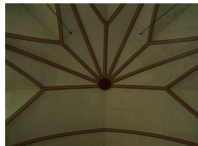
Figure 72 : REF 2005-04-22 JR 064. Nervures au point de rencontre entre la nef et l'abside
