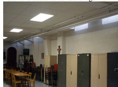
Figure 49 : REF 2005-05-12 LB 061 Salle sous la bibliothèque : notez les renforts des pilastres de béton
