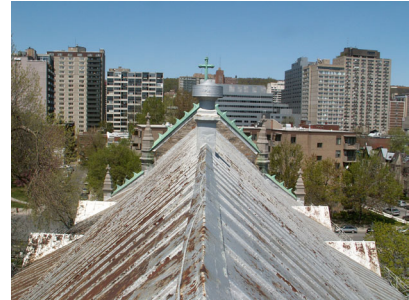
Figure 76 : REF 2005-05-13 LB 168 Vue générale de la toiture vers le nord
