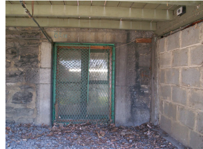
Figure 47 : REF 2005-05-12 LB 017 Détail de fondation de la maison Judah originale
