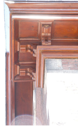
Figure 44 : REF 2005-05-05 LB+JR 015 Détail de la corniche
