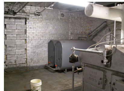
Figure 46 : REF 2005-05-12 LB 012 Salle de chauffe sous le collège
