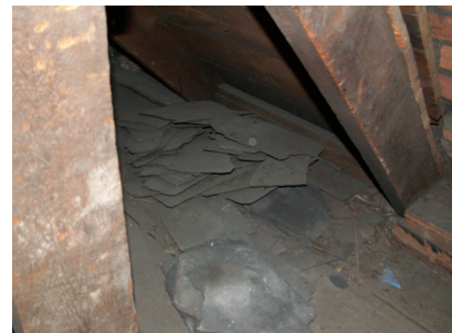
Figure 56 : REF 2005-05-13 LB 132 Détail d'ardoise dans l'entretroit du couvent
