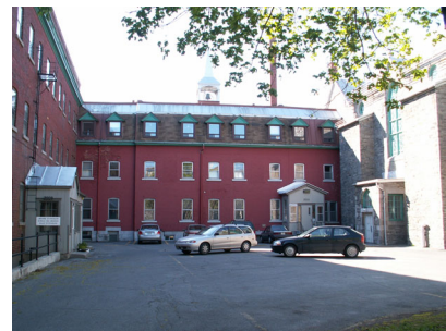
Figure 11 : REF 2005-05-12 LB 001 Vue d'ensemble de la cour intérieure en stationnement
