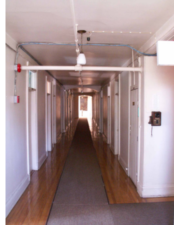
Figure 13 : REF 2005-05-12 LB 113 Vue intérieure du collège transformé en couvent
