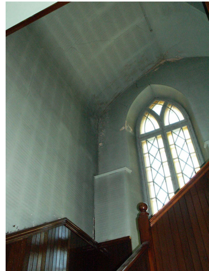
Figure 74 : REF 2005-05-13 LB 085 Escalier d'accès au jubé; notez les lattes de plâtre très visibles
