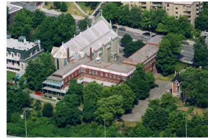
Figure 21 : Arbour_234_007 Vue d'ensemble des jardins du couvent
