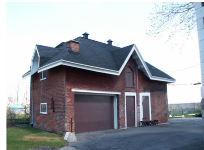
Figure 45 : REF 2005-05-05 LB-JR 008 Vue du garage de service
