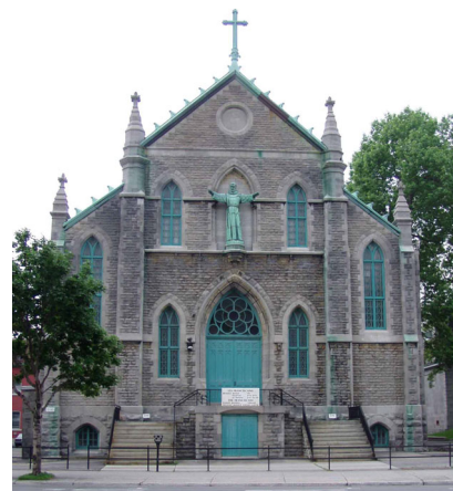
Figure 17 : REF 2005-06-08 JR 030 Façade de la chapelle Saint-François
