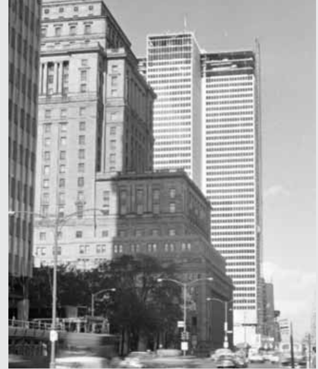
Place Ville-Marie en construction, 1961
