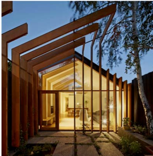
Utilisation de formes traditionnelles pour un bâtiment et sa terrasse
