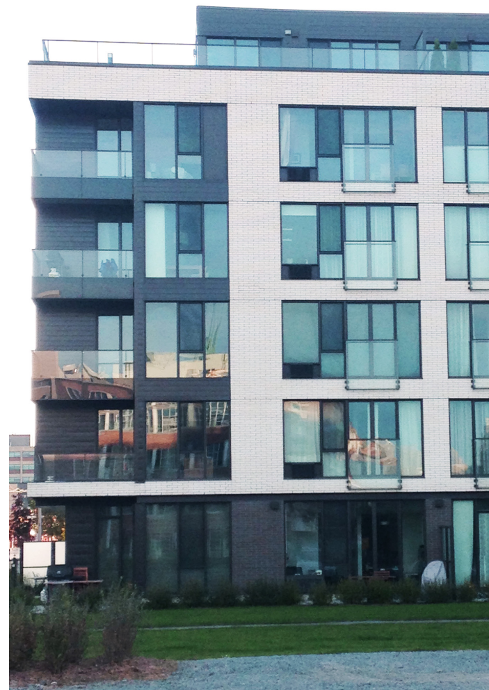
Revêtement de briques blanches / Atelier CT
