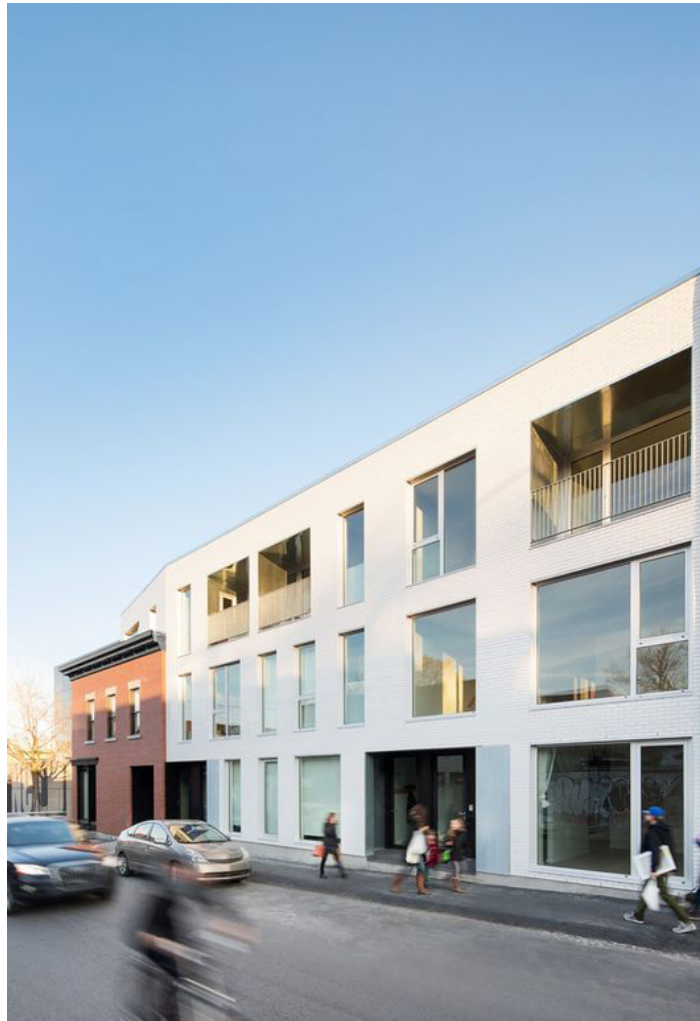
Revêtement de briques blanches / ACDF*
