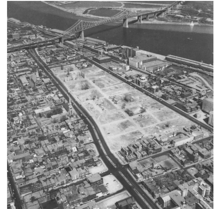
Les 262 immeubles du Faubourg à m'lasse ont été démolis. Photos tirées du livre Quartiers Disparus
