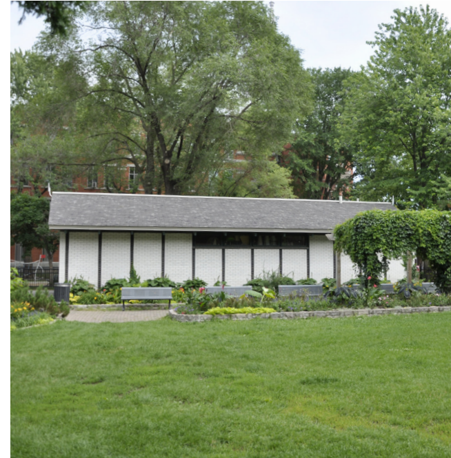
3 - Pavillon de parc
