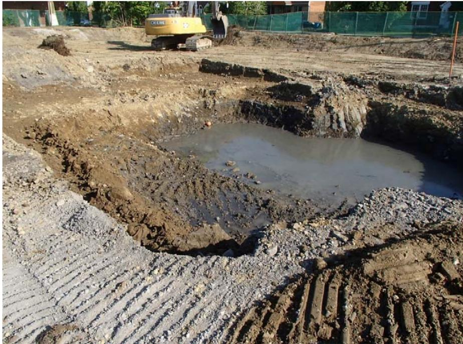
Photo 4 – Sur-excavation de l'excavation EXC-1 (24 mai 2016).
