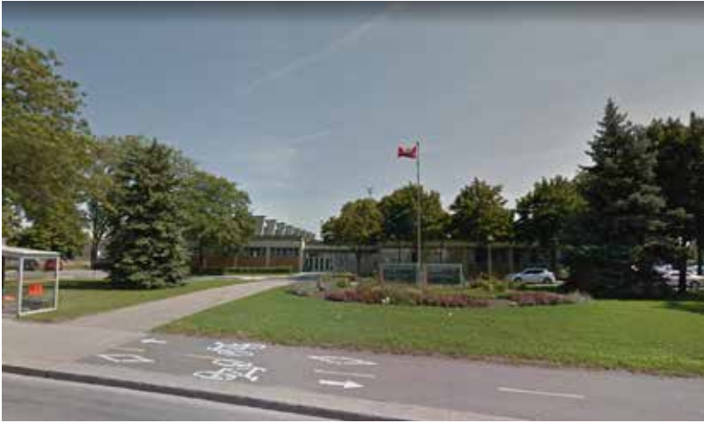
Centre de formation du Service des incendies de Montréal, rue Notre-Dame Est
