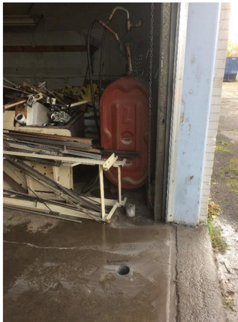
Photographie 3 : réalisation du forage F-INT3
