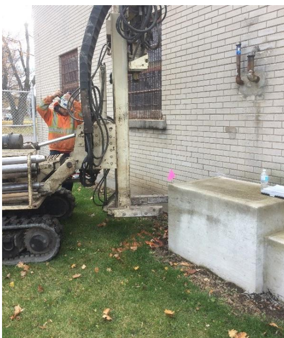
Photographie 2 : réalisation du forage F-3
