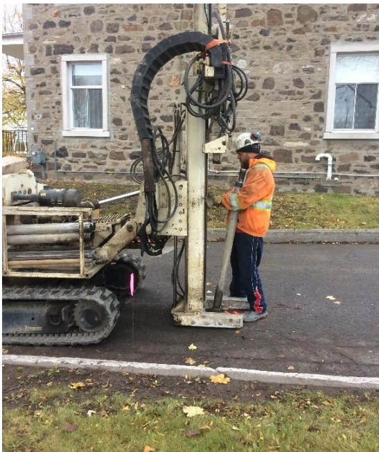
Photographie 1 : réalisation du forage F-15
