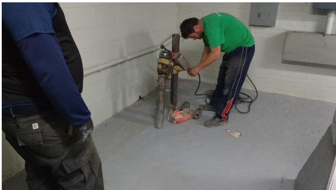
Photographie 4 : réalisation du forage F-INT2
