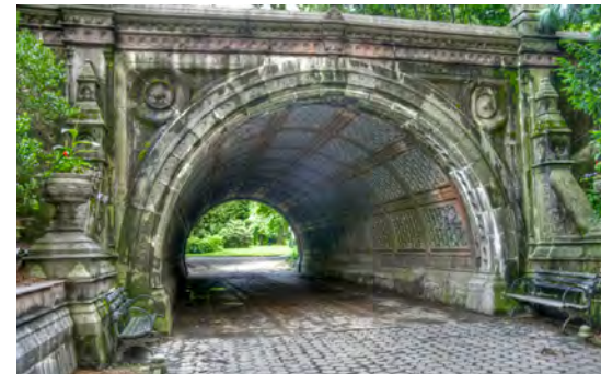
11- Cleft Ridge Span, un tunnel pour le passage des piétons sous Wellhouse Drive
