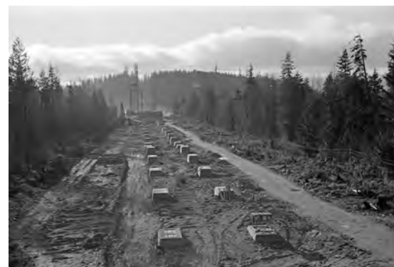
21- Construction de la causeway et du pont, 1937
