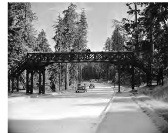
23- Pont piéton au-dessus de la causeway, 1941
