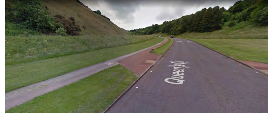
11- Trottoir (rouge) qui empiète sur la piste cyclable et réduit drastiquement sa largeur
