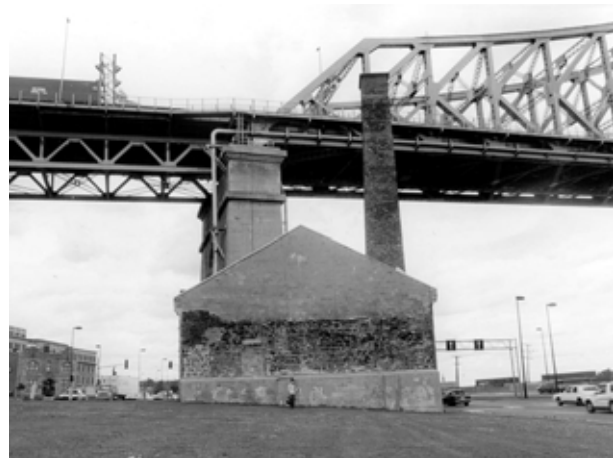
4. Usine de pompage Craig, 2004
