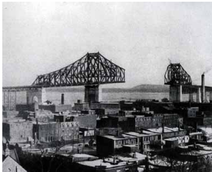
25. Construction du pont Jacques-Cartier, 1929
