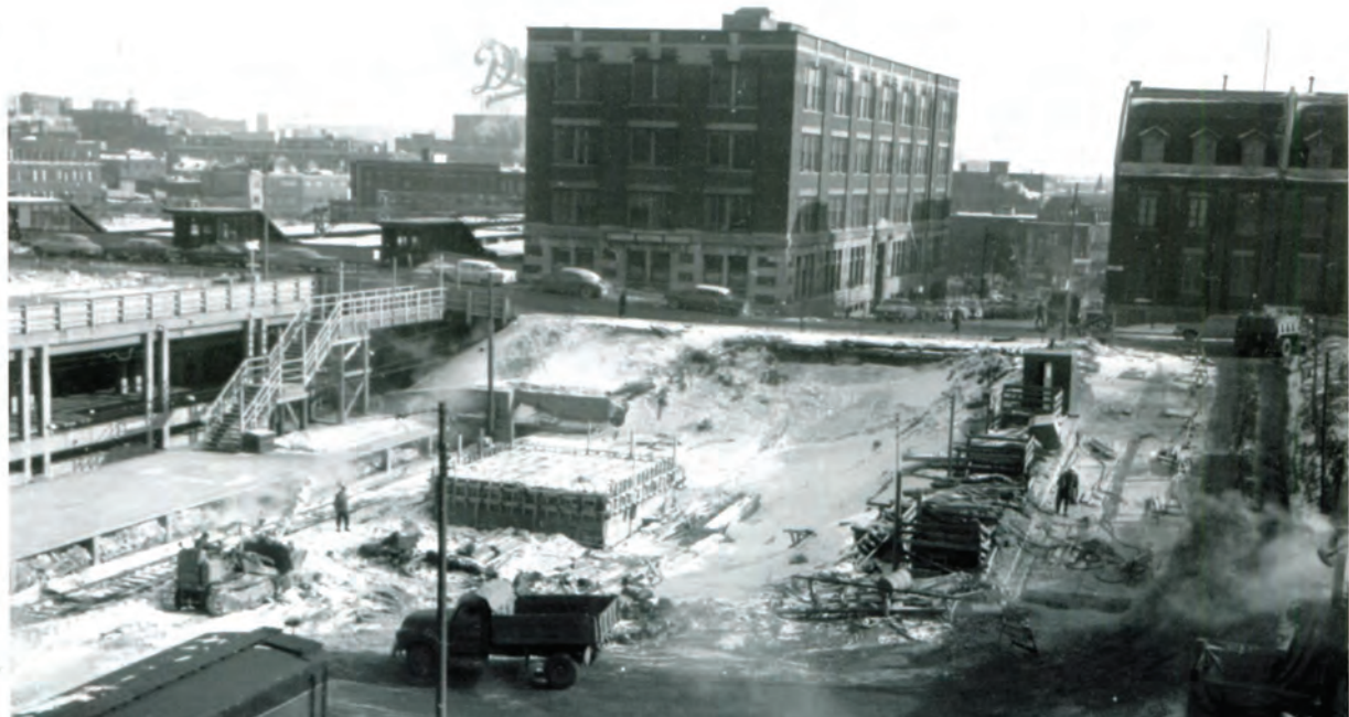
Démolition de la première gare, tiré de Anthony Clegg (2008), The Mount Royal Tunnel. Canada's First Subway , Pickering, Railfare DC Books.
