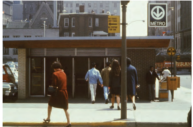
Premier édicule de la station McGill sur le boulevard de Maisonneuve, Archives et ressources informationnelles. Secrétariat général et direction exécutive affaires juridiques, STM, McGill S10 10.1.13,2 #25
