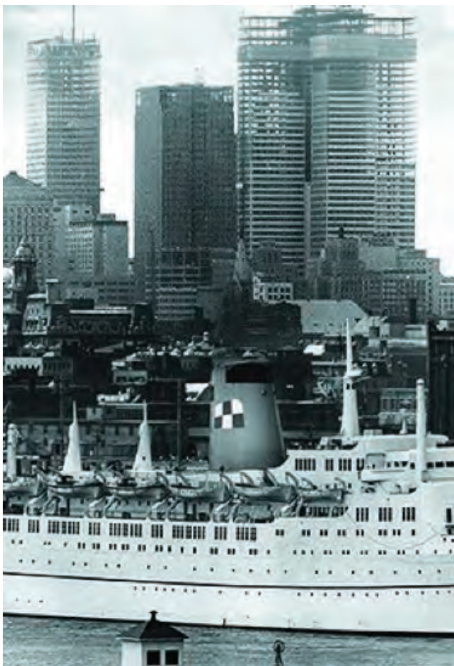
Les nouvelles tours en construction du centre-ville de Montréal, tiré de France Vanlaethem et al. (2012), Place Ville Marie. L'immeuble phare de Montréal , Montréal, Éditions Québec Amérique.
