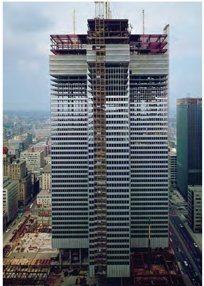
Place Ville Marie lors de sa construction, c.1961, tiré de France Vanlaethem et al. (2012), Place Ville Marie. L'immeuble phare de Montréal , Montréal, Éditions Québec Amérique.
