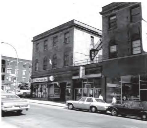
Bâtiment commercial situé à proximité de l'avenue McGill College, c.1978, Archives de la Ville de Montréal.
