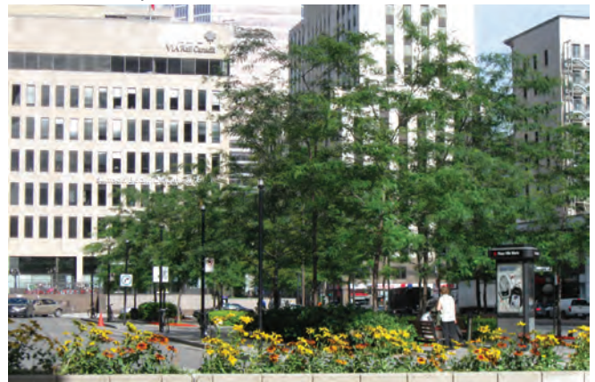
Place Monseigneur-Charbonneau, photo : Jacques Gilbert, Service des grands parcs, du verdissement et du Mont-Royal, Ville de Montréal.
