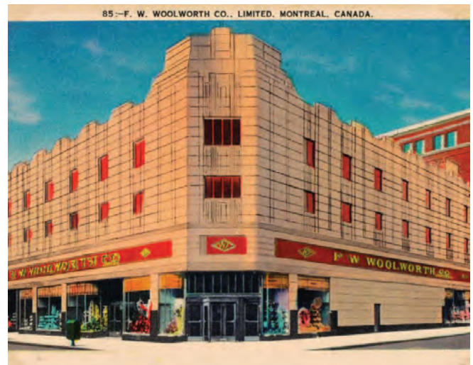
Édifice F.W. Woolworth Building Co., c. 1940, BANQ, CP 027837 CON.
