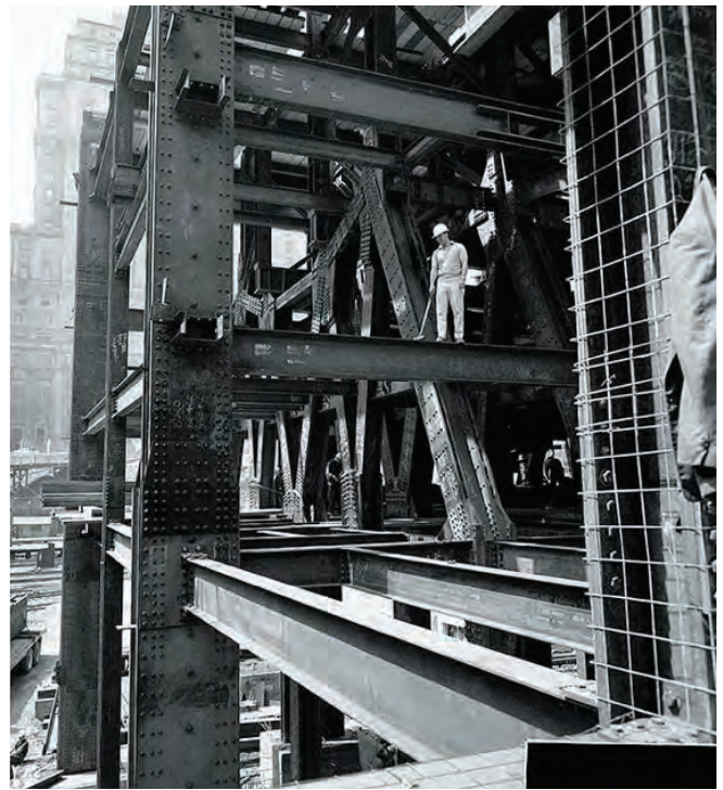
Ouvriers lors de la construction de Place Ville Marie, c.1960, tiré de France Vanlaethem et al. (2012), Place Ville Marie. L'immeuble phare de Montréal , Montréal, Éditions Québec Amérique.
