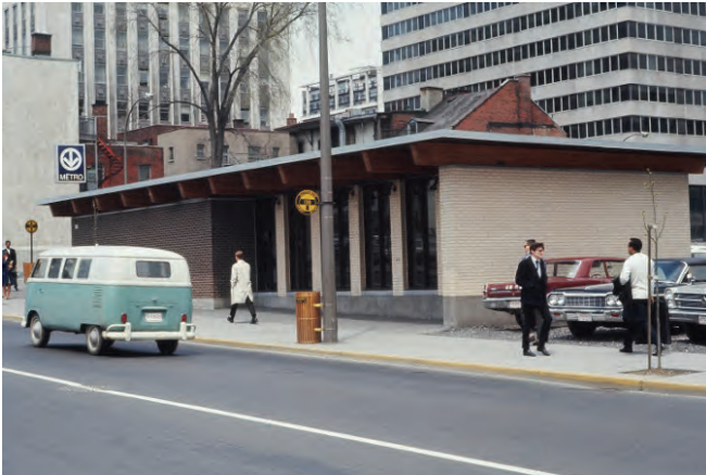
Premier édicule de la station McGill sur le boulevard de Maisonneuve, Archives et ressources informationnelles. Secrétariat général et direction exécutive affaires juridiques, STM, McGill S10 10.1.13,2 #26.
