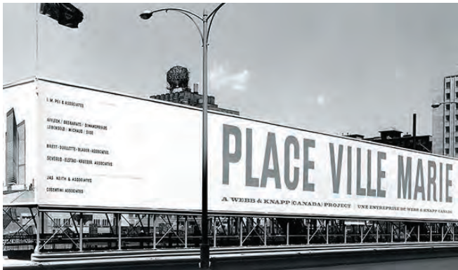
Bureau de chantier de la Place Ville Marie, c. 1958, tiré de France Vanlaethem et al. (2012), Place Ville Marie. L'immeuble phare de Montréal , Montréal, Éditions Québec Amérique.
