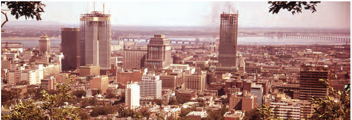
Les tour de la Palace Ville Marie et de la CIBC en construction, 1962, Archives de la Ville de Montréal, vm94-ad123-0101 (1962).
