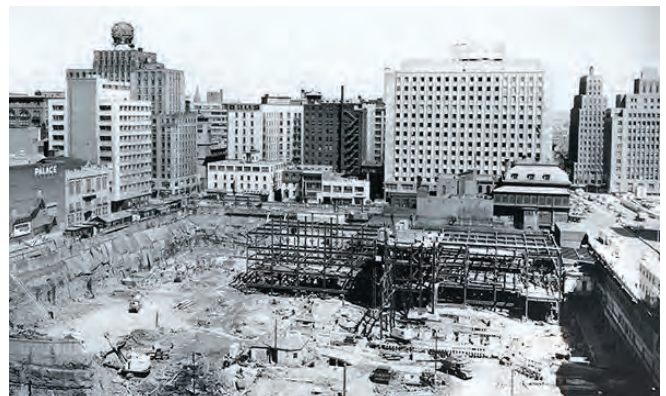
Le chantier à la mi-avril, 1960, tiré de France Vanlaethem et al. (2012), Place Ville Marie. L'immeuble phare de Montréal , Montréal, Éditions Québec Amérique.
