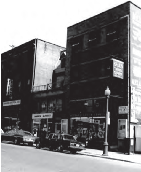
Édifice commercial sur la rue Mansfield, c.1978, Archives villes de Montréal.
