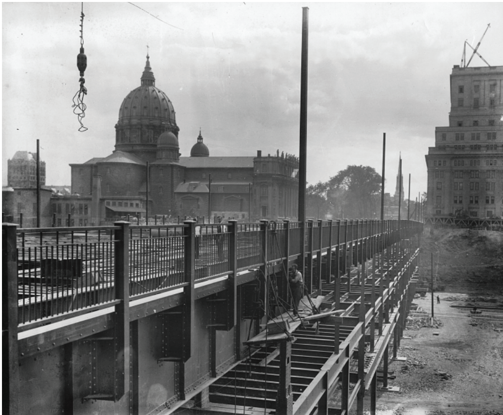
Construction d'un pont au-dessus du chemin de fer du CN, rue Dorchester, 1930, Musée McCord, MP-0000.587.130.
