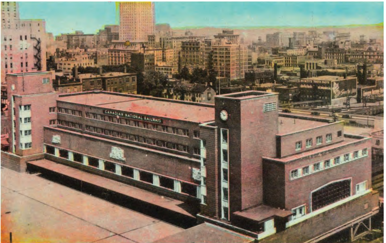
Gare centrale, réseau C.N.R., Montréal, c. 1940-1950, BAnQ, CP 026848 CON.
