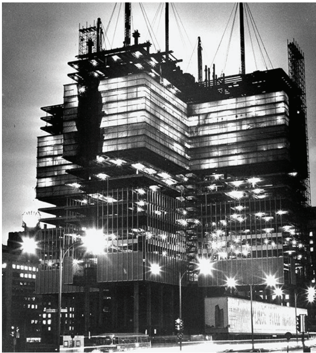
Bureau de chantier de la Place Ville Marie, c. 1958, tiré de France Vanlaethem et al. (2012), Place Ville Marie. L'immeuble phare de Montréal , Montréal, Éditions Québec Amérique.
