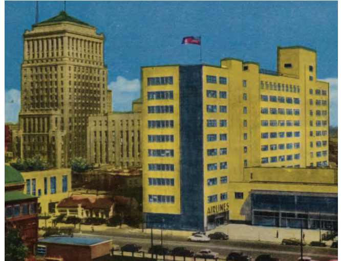
Aviation Building, Montreal, PQ., Canada, 96, BAñQ, N° de notice : 0003812231.
