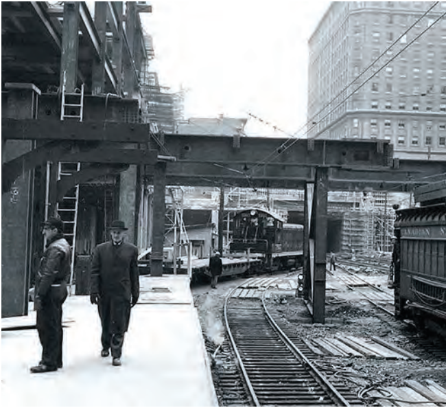
Chantier de la Place Ville Marie au niveau des rails du CN, c.1960, tiré de France Vanlaethem et al. (2012), Place Ville Marie. L'immeuble phare de Montréal , Montréal, Éditions Québec Amérique
