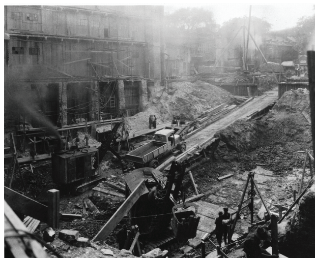
Construction du magasin Eaton, 1925, Musée McCord, MP-0000.2092.4.
