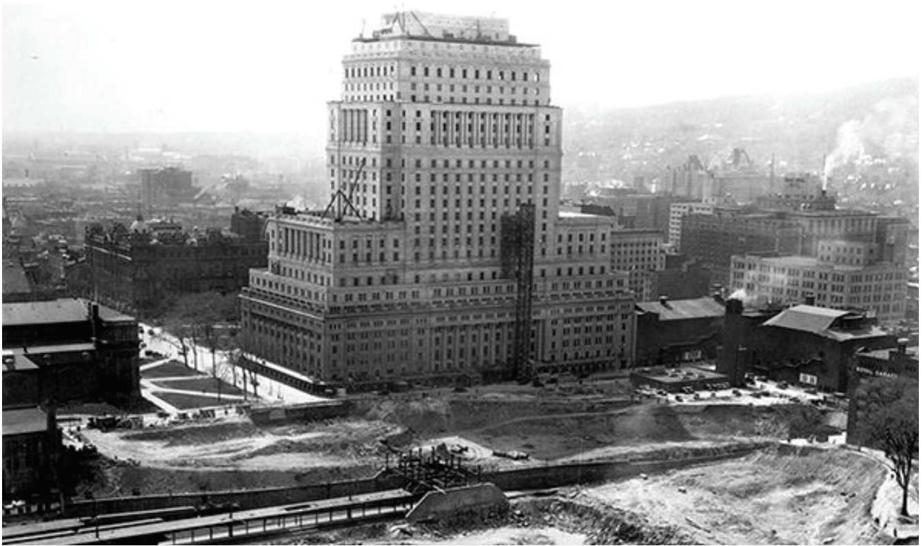
La tranchée afin d'accueillir la future gare Centrale, c. 1920, tiré de France Vanlaethem et al. (2012), Place Ville Marie. L'immeuble phare de Montréal , Montréal, Éditions Québec Amérique.
