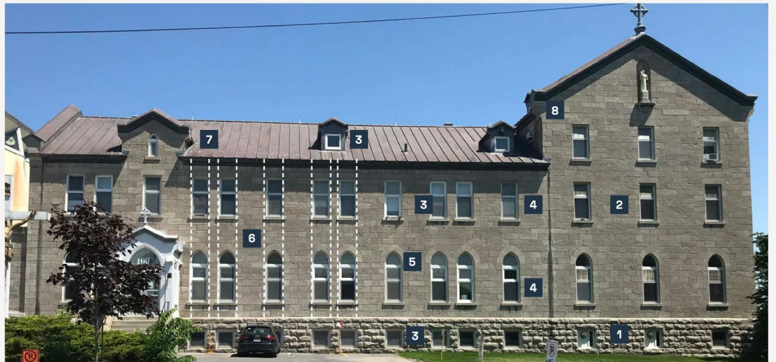
Photo de la façade ouest du couvent, 2018
