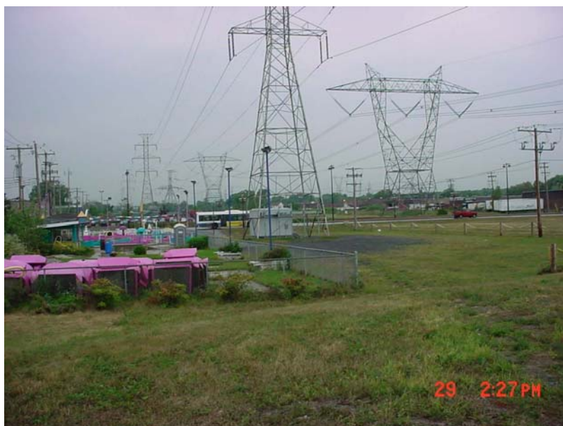
Figure 4 Vue vers le nord d'une partie de l'emprise d'Hydro-Québec (document déposé 5.1, page 8)
